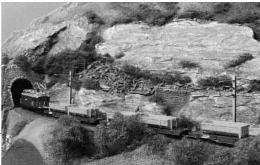
Die FO-HGe 4/4 hat für heute einmal den Aus-hubtransport übernommen. In der Nähe des Fuchsenwinkeltunnels sind die leeren Mulden auf dem Weg zurück zur Tunnelbaustelle.
