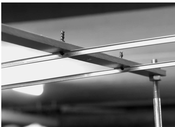
Detail der Befestigung des Schienenprofils unten am Querträger.
